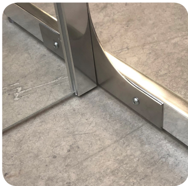
Vidrios a ras del suelo
