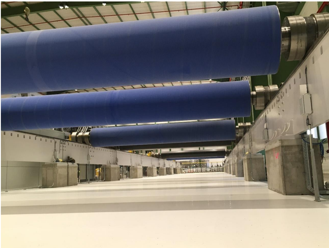
Detalle de acabado de un revestimiento de resina en la industria papelera.
