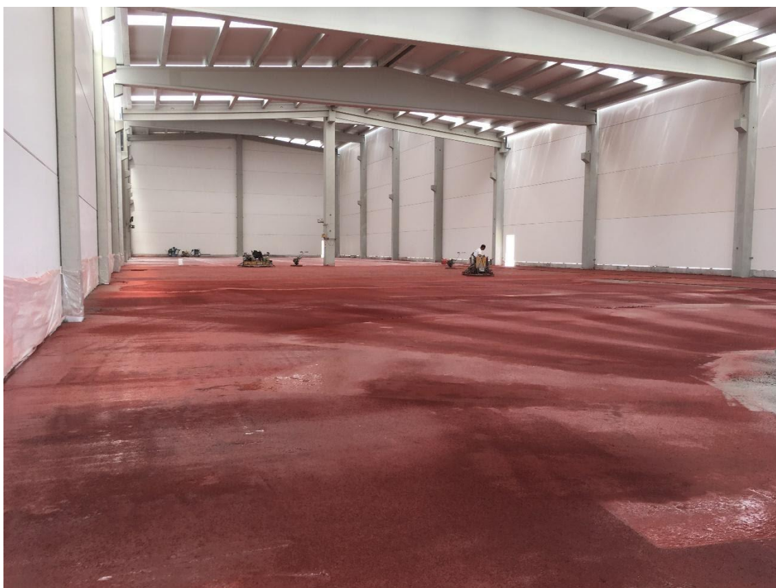
Ejecución de un pavimento con capa de rodadura MAPETOP N AR6 (color rojo)
