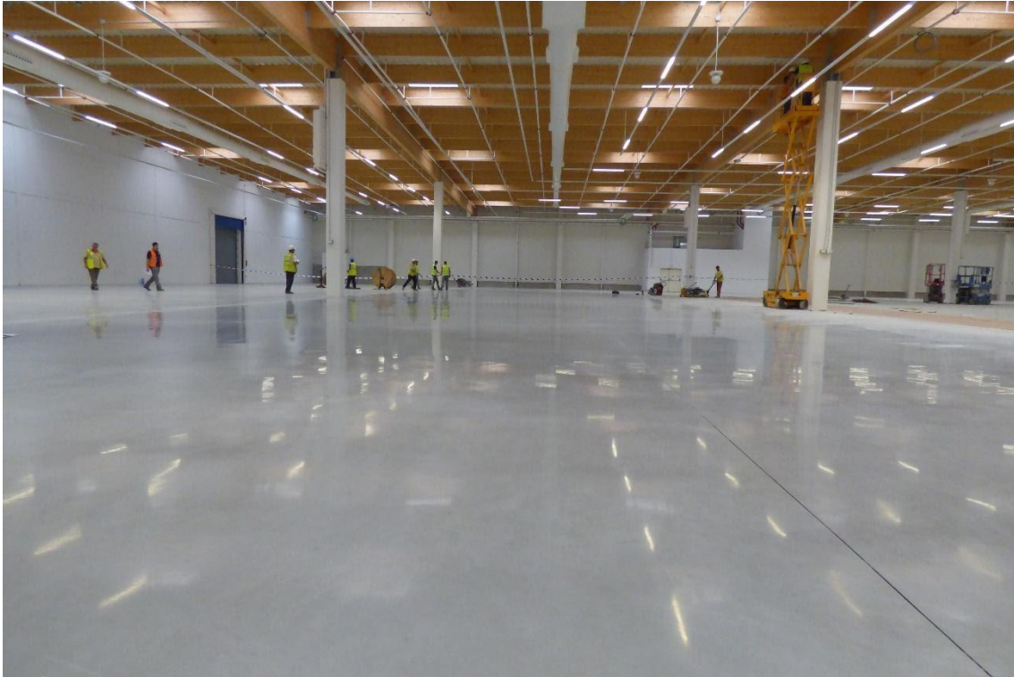
Pavimento de hormigón ejecutado con la filosofía "Soluciones 360º" y MAPECRETE SYSTEM de MAPEI.
