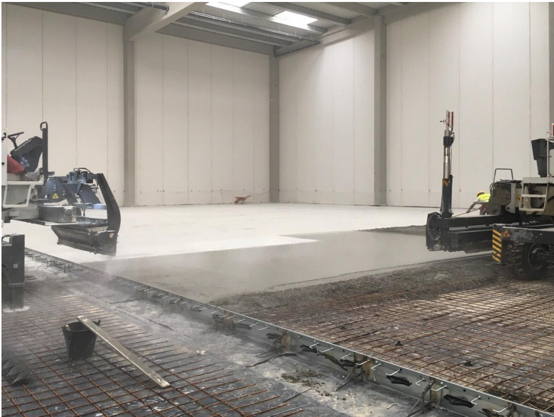
Detalle de la construcción de un pavimento de hormigón.
