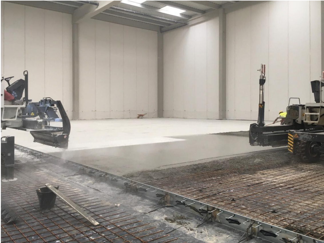
Detall de la construcció d'un paviment de formigó.
