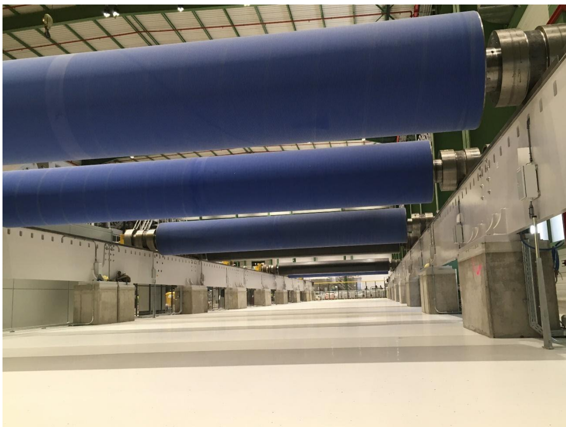
Detall d'acabat d'un revestiment de resina en la indústria paperera.
